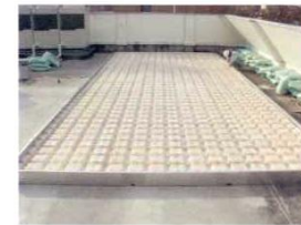
R-パネルの設置
