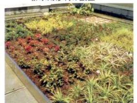
マルチング材を敷き均し完成
