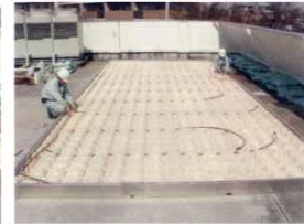
点滴灌水ホースの敷設
