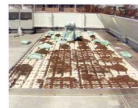
人工土壌の敷き均し
