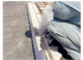
端末処理ならびに排水用砂利の設置
