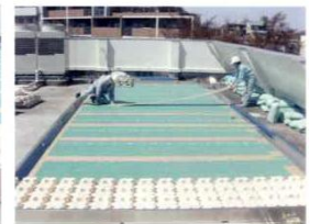
排水層固定テープの設置
