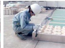
土留めパネルの設置
